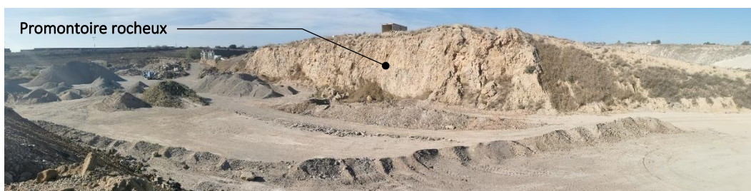
Figure 5 : Front rocheux en extrémités Sud-Est et Nord-Ouest, ainsi que sur le promontoire (12/10/2021)
